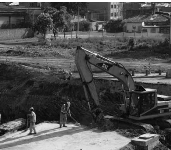
Las obras de la calle 26 Foto: Diego Mayorga.
